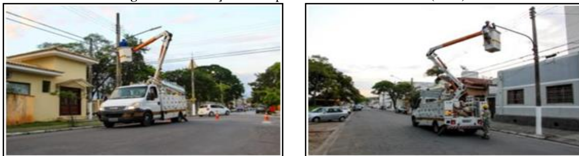
Figura 65. Instalação de lâmpadas LED na Zona Central (2018).
