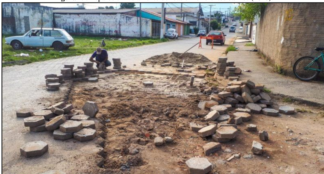
Figura 49. Reparos e nivelamento de ruas em diferentes bairros (2018).
