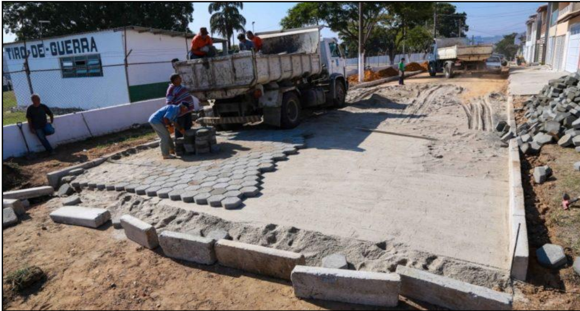
Figura 51. Reparos e nivelamento da Rua Dr. José Carlos Caputo (2018).
