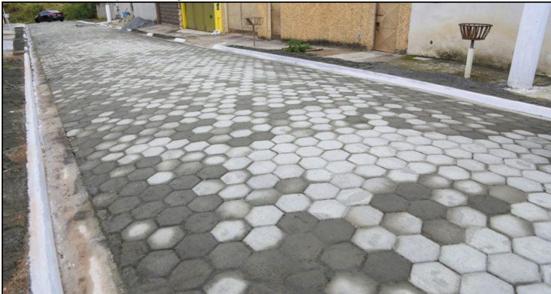
Figura 52. Reparos e nivelamento da Rua Juvêncio Gomes (2019).
