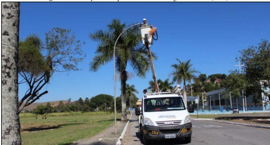
Figura 63. Instalação de lâmpadas LED na Av. Rogério Mariano (2018).
