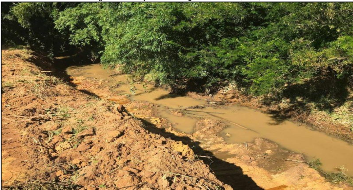
Figura 56. Limpeza do córrego da Barrinha (2019).
