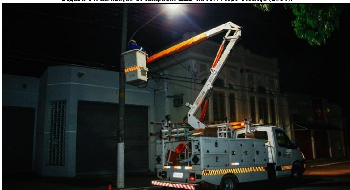
Figura 64. Instalação de lâmpadas LED na Av. Jorge Tibiriçá (2018).
