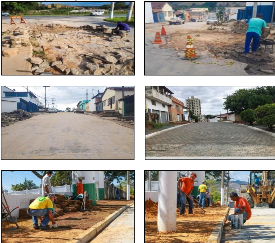
Figura 50. Reparos e nivelamento de ruas em diferentes bairros (2018 / 2019).
